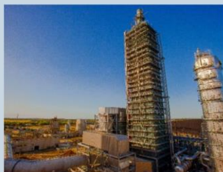
CO 2 回収プラント 市場シェア世界1位 ※2
